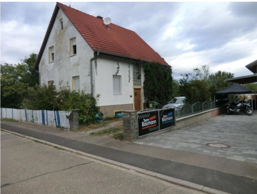
Abb. 2 Wohngebäude, Eingriffsbereich von Süden
